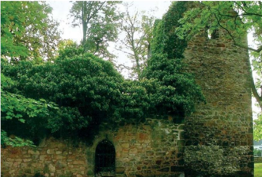
Руіны Фёпштэцкай царквы ў Зальцгітэры-Бадзе.
